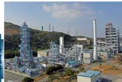
図2: EAGLE パイロットプラント
