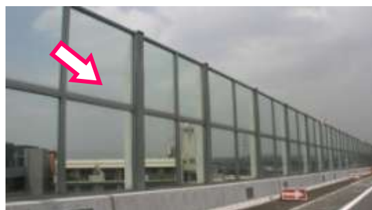
高速道路の防音壁
