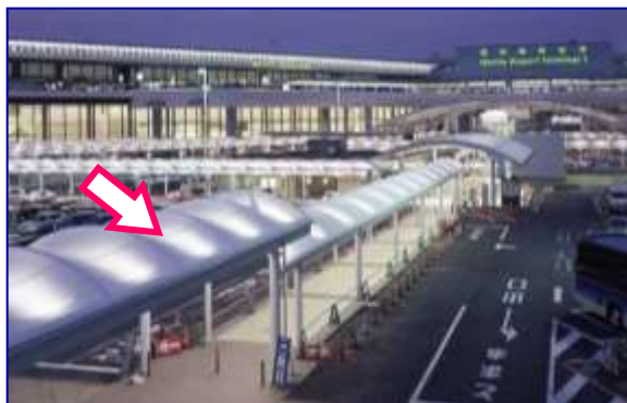
成田国際空港施設の屋根
