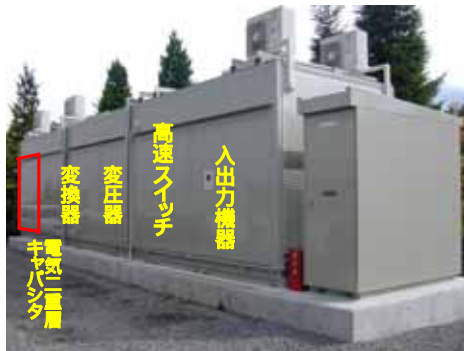
図4 電気二重層キャパシタの概要
