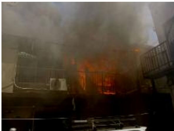
写真 1 - 1 延焼中の建物の状況
