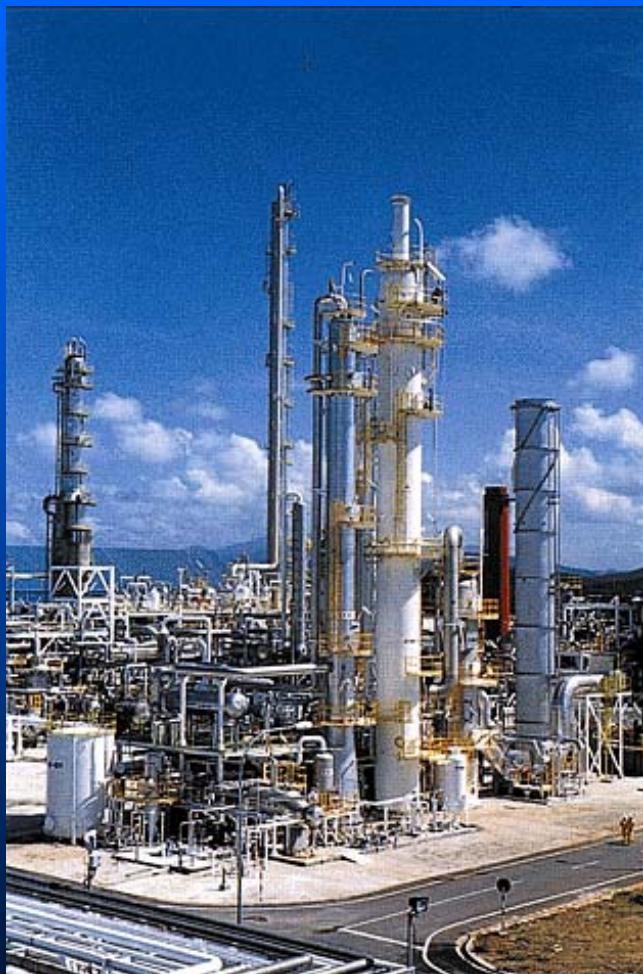
CO 2 回収プラント（マレーシア）
