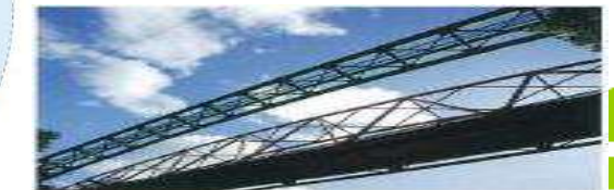
天然ガスパイプライン
