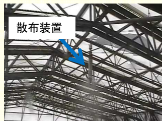
<飛散防止材の散布状況>
