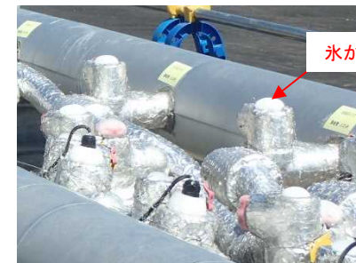
陸側遮水壁 凍結開始後の状況
