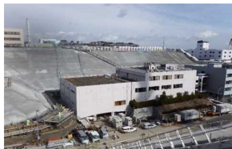
モルタル吹付施工後
