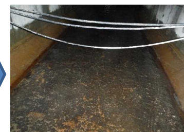
排水路の清掃状況（清掃後）
