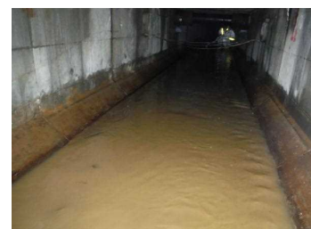
排水路の清掃状況（清掃前）
