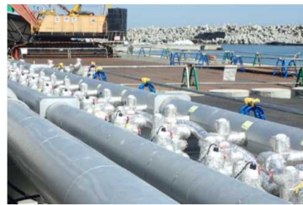
陸側遮水壁 凍結開始後の状況
