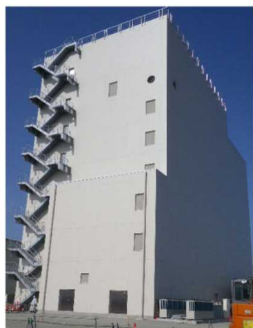
大型休憩所(外観)
