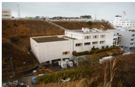
モルタル吹付施工前
