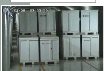
固体廃棄物貯蔵庫
