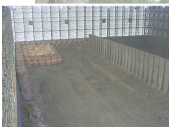
瓦礫保管テント内
