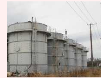
堰カバー設置前
