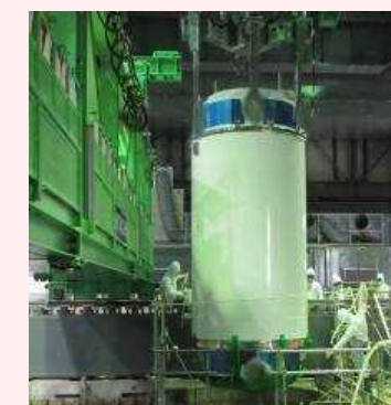
燃料取り出し状況
