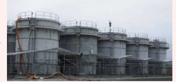
堰カバー設置後
