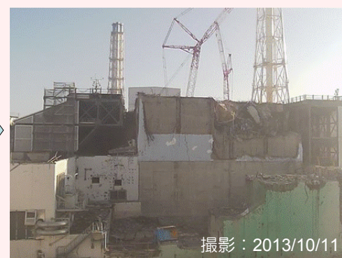
大型ガレキ撤去後
