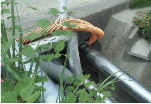
①排水路内
