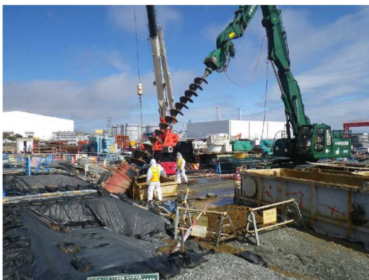
掘削時の状況
