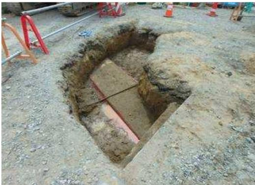
写真① 接続桝部 埋設物調査
