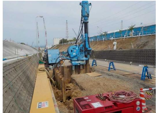
写真③ 西側エリア接続桝部 土止矢板打設
