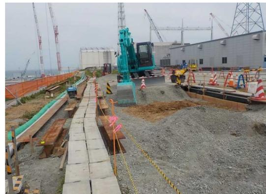
写真④ 地下水BPエリア接続桝 既設設備防護
