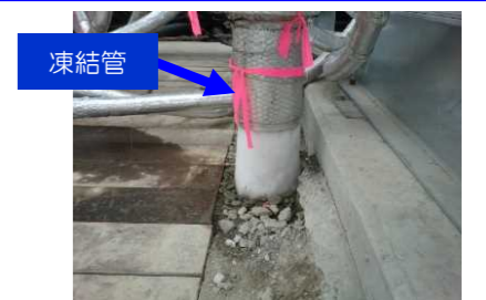
(陸側遮水壁 試験凍結箇所例)
