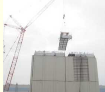
<屋根パネル取り外し状況>
