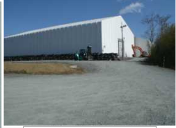
瓦礫保管テント
