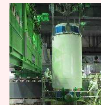
燃料取り出し状況
