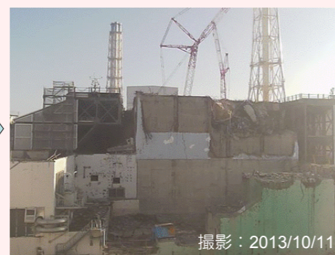
撮影：2013/10/11 大型ガレキ撤去後
