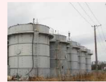
堰カバー設置前
