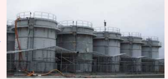
堰カバー設置後
