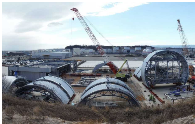
カバー架構部材の保管状況（2015.3.10撮影）
