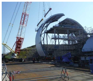
屋根部材の組立状況（2014.10.11撮影）
