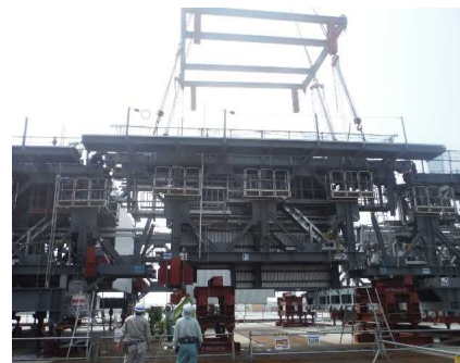
ガーダーの組立状況（2014.6.23撮影）
