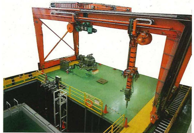
遠隔操作訓練状況写真（訓練施設） （背景マスキング）
