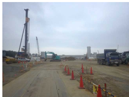
現場の全景写真
