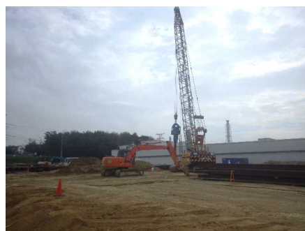
作業状況写真
