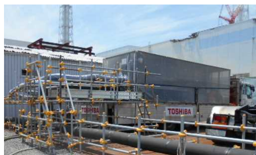
モバイル式処理装置
