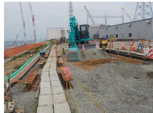
写真④ 地下水BPエリア接続柵 既設設備防護
