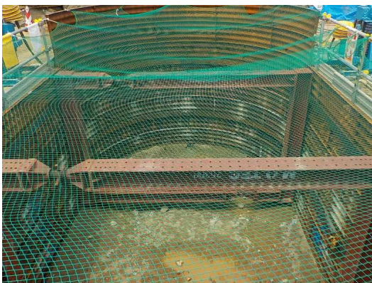
写真② 接続柵部 立坑構築
