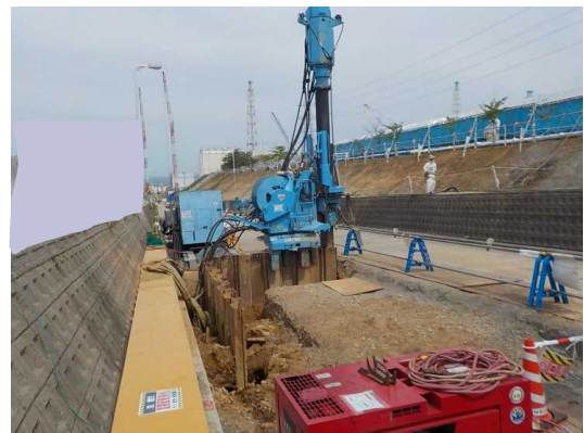
写真③ 西側エリア接続柵部 土止矢板打設
