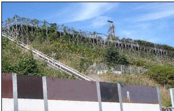
【写真④(35m盤)】1～4号法面:モルタル吹付け施工後
