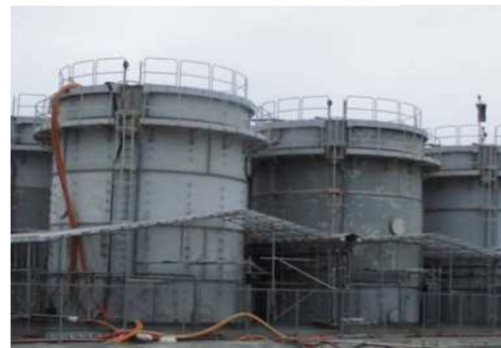
タンク堰内雨水への対応状況
