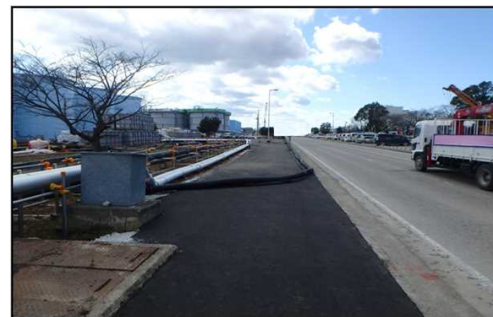
【写真】Hタンクエリア：舗装施工後
