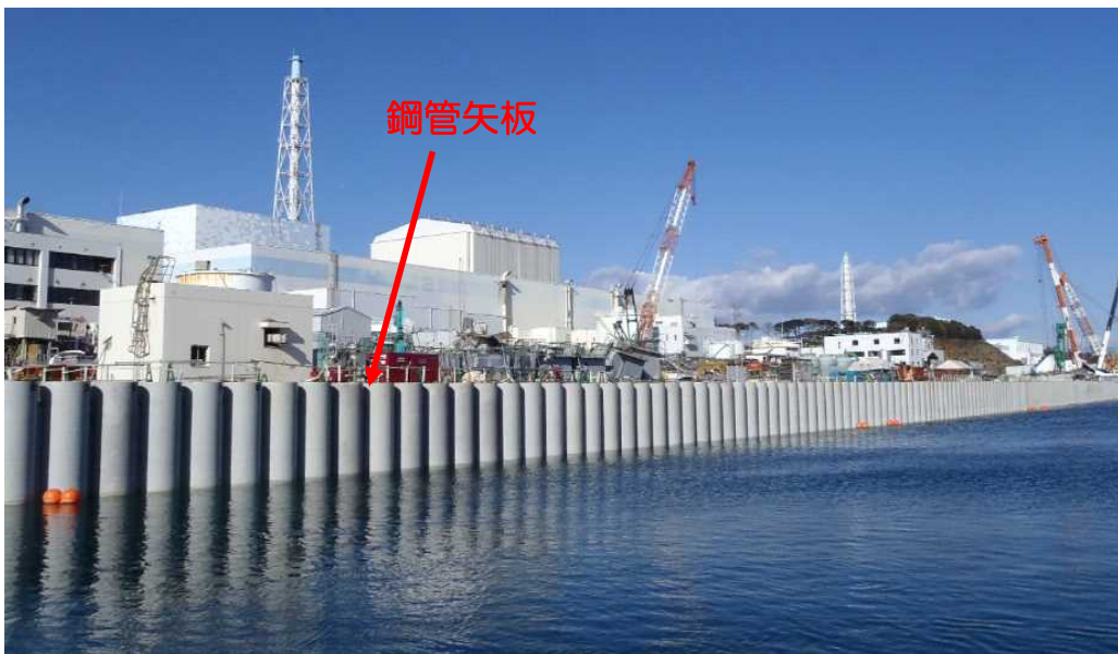
海側遮水壁の設置状況
