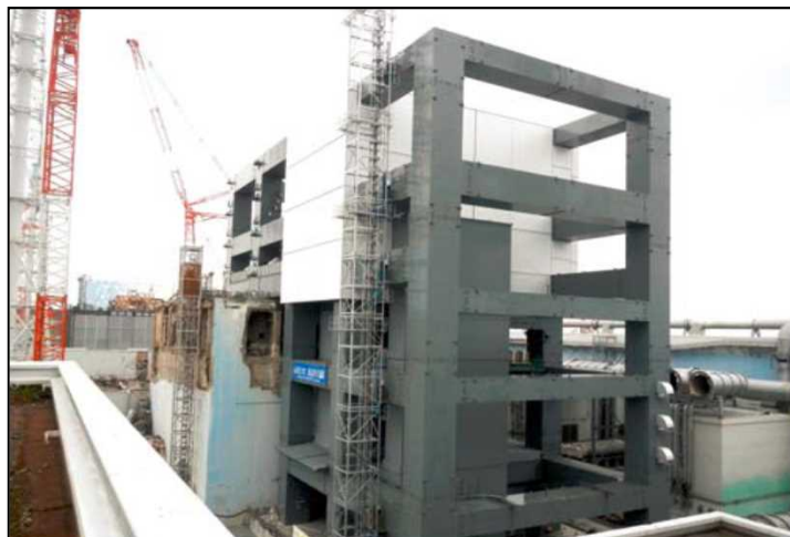
鉄骨建方完了 (撮影日：2013年5月29日)
