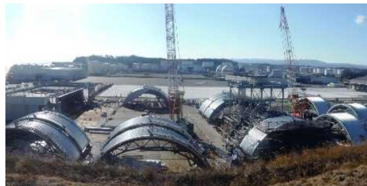
建屋カバーの製作状況（小名浜）
