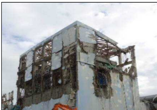
ガレキ撤去前 (撮影日：2011年9月22日)
