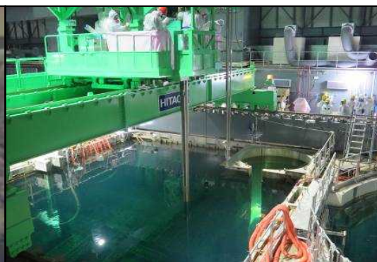
燃料取り出し作業 (撮影日：2013年11月18日)
