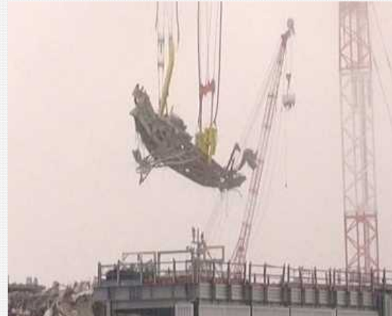
＜燃料交換機撤去作業の状況＞
