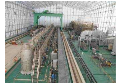
(高性能多核種除去設備)
