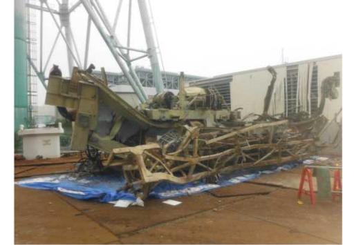
(8/21に撤去した燃料交換機)
