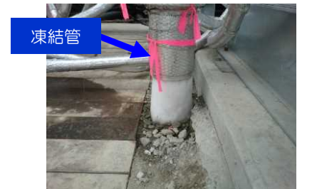
(陸側遮水壁 試験凍結箇所例)
