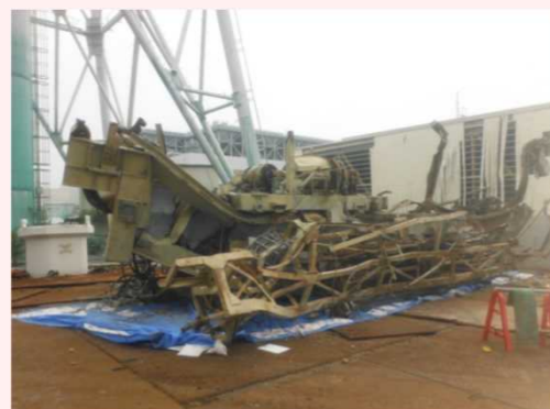
撤去した燃料交換機
