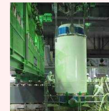
燃料取り出し状況
