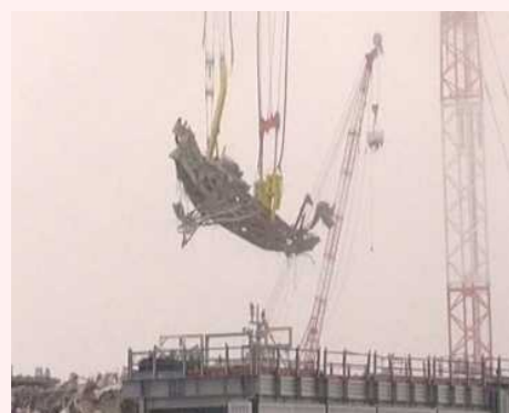
8/2 燃料交換機撤去作業の様子
