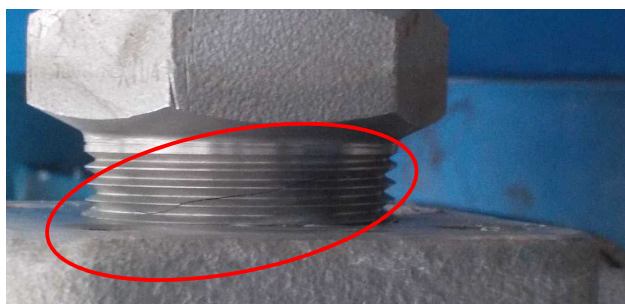
継手ネジ部の割れ
