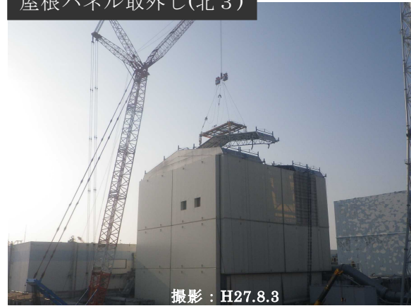
屋根パネル取外し(北3)
