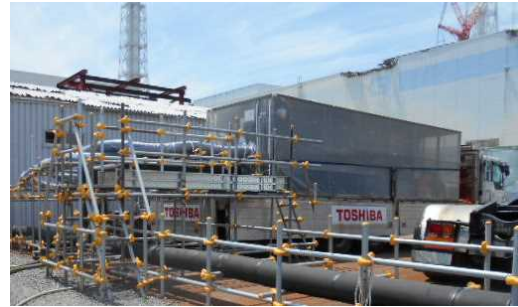
モバイル式処理装置
