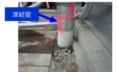
(陸側遮水壁 試験凍結箇所例)
