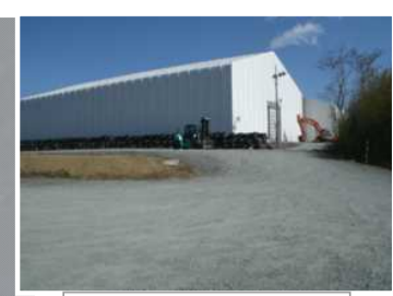
瓦礫保管テント
