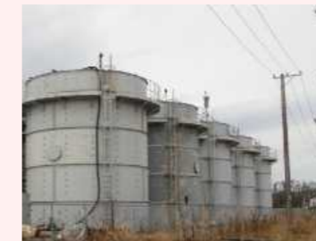
堰カバー設置前
