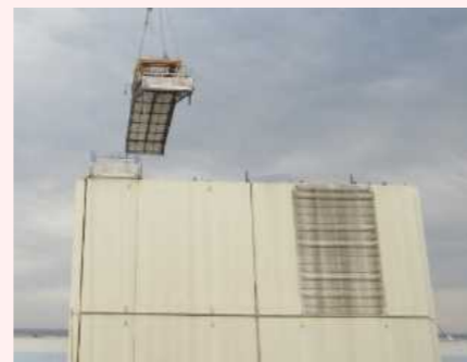
屋根パネル取り外し状況
