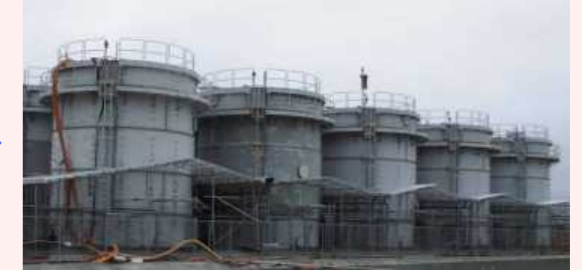
堰カバー設置後
