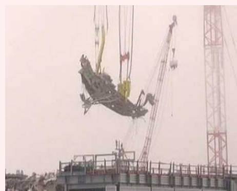
8/2 燃料交換機撤去作業の様子
