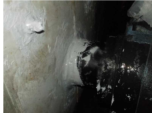
応急措置実施状況
