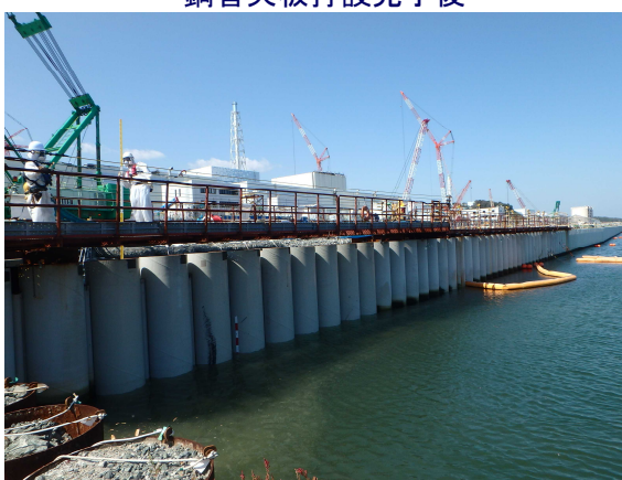
鋼管矢板打設完了後
