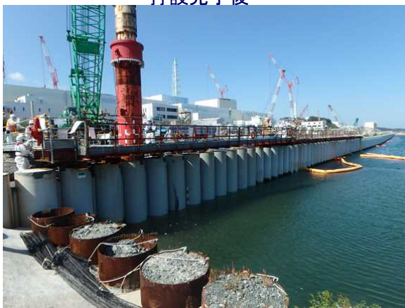
鋼管矢板打設完了後
