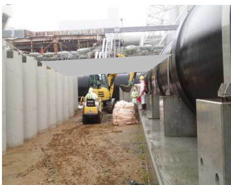
写真② 埋立エリア部 基盤成形
