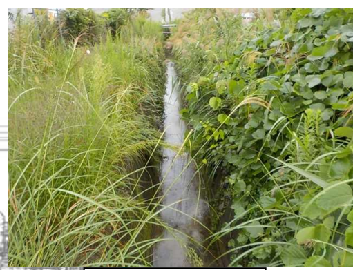
上流部清掃予定箇所
