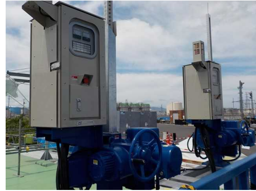
写真 自動・遠隔制御盤設置状況
