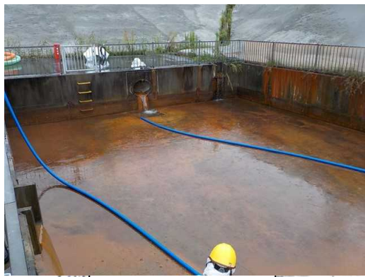
上流部清掃状況
