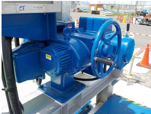
写真 ゲート巻上機電動化状況
