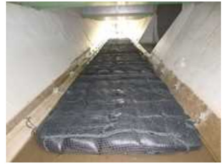
<浄化材の設置>
