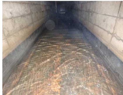
<排水路清掃状況>
