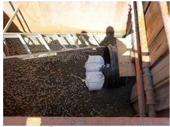
写真④ 大熊通り 排水管路構築
