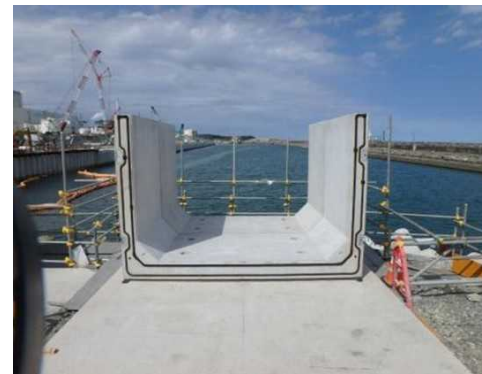
写真③ 放流口部 放流口開渠設置
