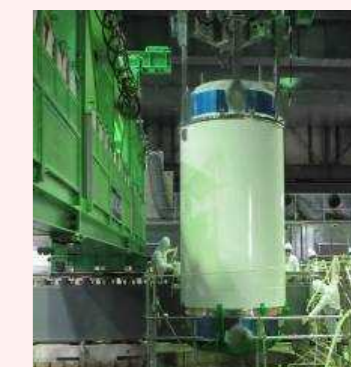
燃料取り出し状況
