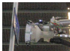
8mの高所における ドライアイス除染の状況
