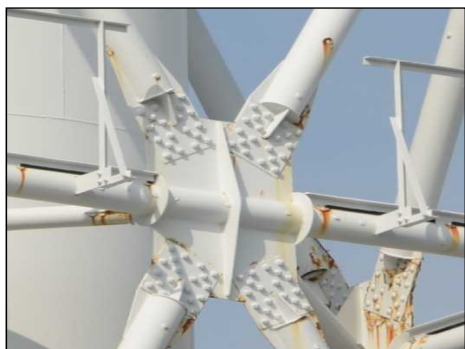
① 南側（GL100m付近） 接合部
