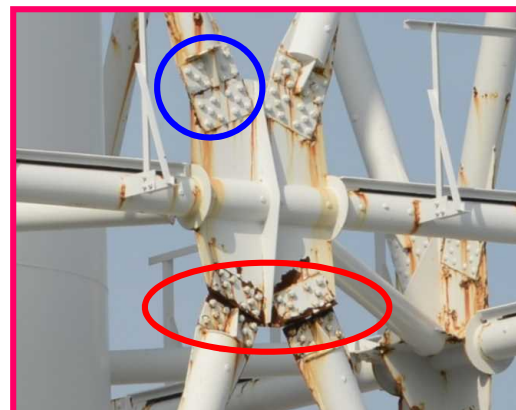
破断及び変形と判断した箇所の例（2015年9月）
