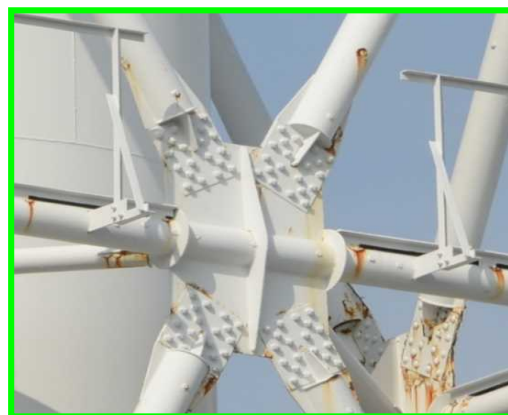
健全と判断した箇所の例（2015年9月）
