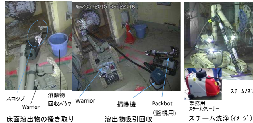
図5：2号機X-6ペネ周辺除染状況
