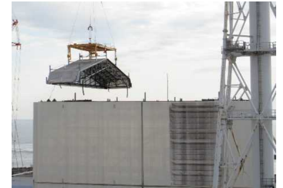
(1号機建屋カバー解体作業の状況)
