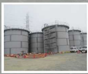
タンクの設置状況
