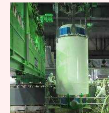
燃料取り出し状況
