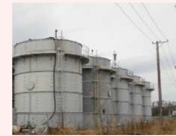
堰カバー設置前
