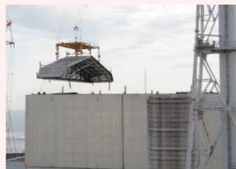
屋根パネル取り外し状況
