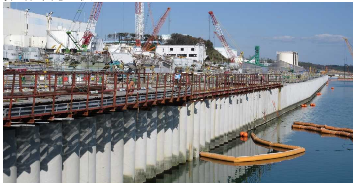
〈閉合作業完了後〉
