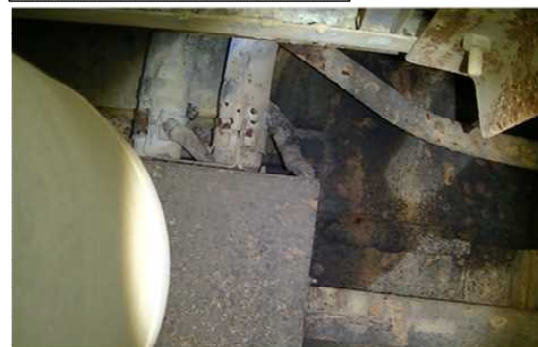
流入箇所下部の写真
