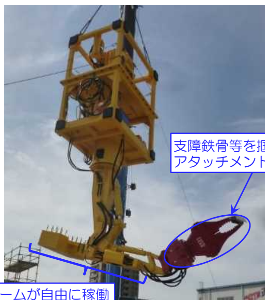
把持用アタッチメントを装着した撤去装置全景
