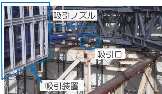
コンクリート片等の小ガレキ吸引状況
