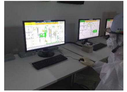
制御室 試験作業状況
