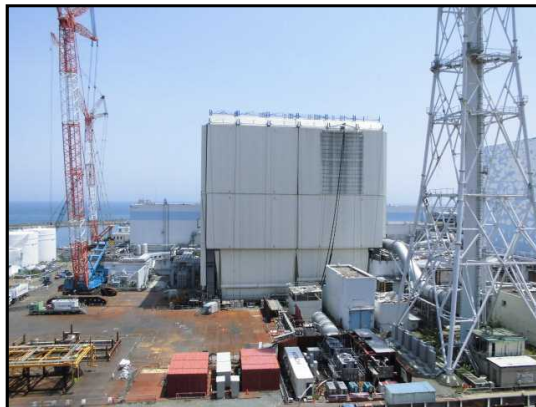
現場状況写真
