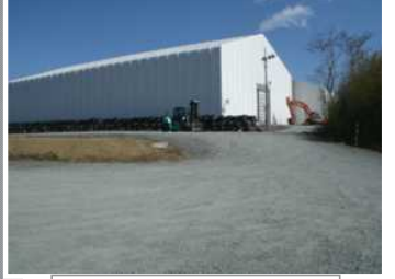
瓦礫保管テント
