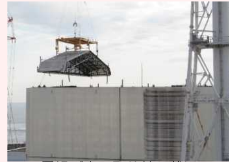
屋根パネル取り外し状況
