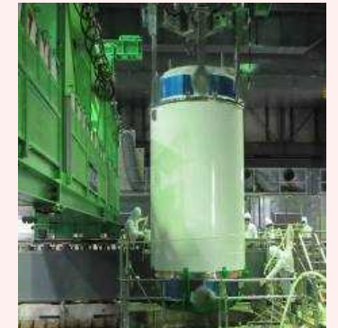
燃料取り出し状況
