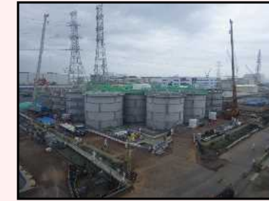
解体開始時の様子
