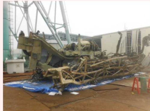
撤去した燃料交換機
