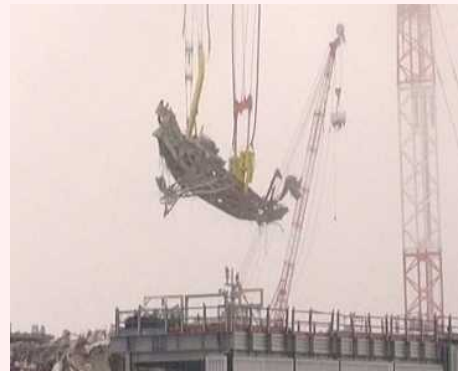
8/2 燃料交換機撤去作業の様子
