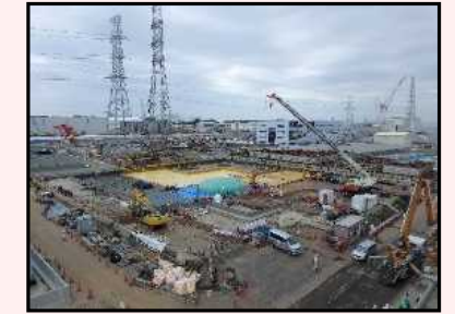
解体後の様子
