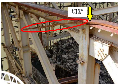
支障となる鉄骨等の例
