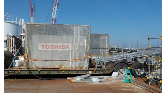
1号機放水路浄化装置（吸着塔ユニット）
