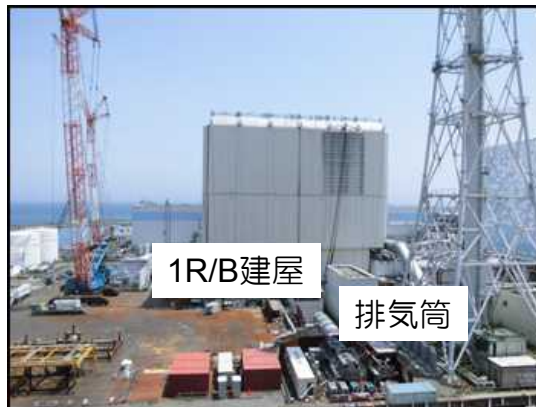
現場状況写真
