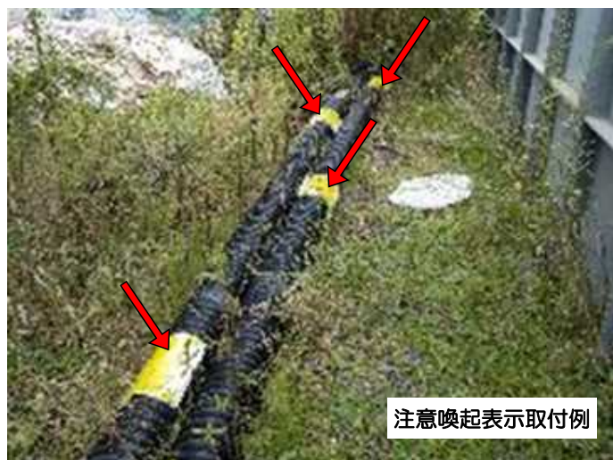
さらなる注意喚起のための現場表示の設置
