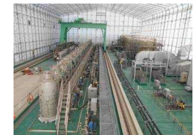
(高性能多核種除去設備の設置状況)
